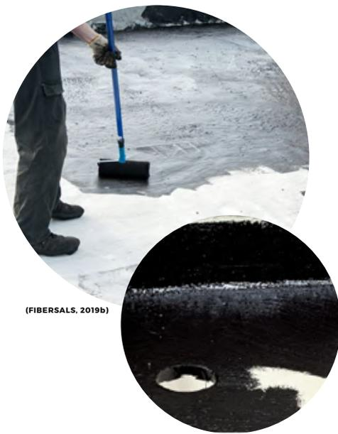
Após 3 dias de secagem da argamassa de regularização, aplicar uma demão de emulsão asfáltica para imprimação ou solução asfáltica para imprimação respeitando-se o respectivo consumo por m<sup>2</sup> e tempo de secagem.
